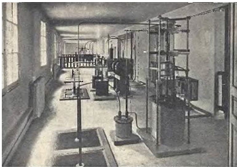
Galerja w Ambulatorium (na I p.), zawierająca aparaty do Roentgenoterapii. Aparaty te dają prąd o wysokim napięciu do gabinetów leczniczych, znajdujących się na parterze
